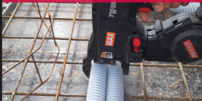
Liage des fourreaux en incorporation
