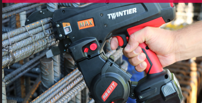
Ligatures d'ensembles de barres d'armature
